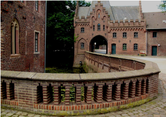
Schloss Paffendorf , Bergheim-Paffendorf Blick vom Innenhof zum Haupteingang
